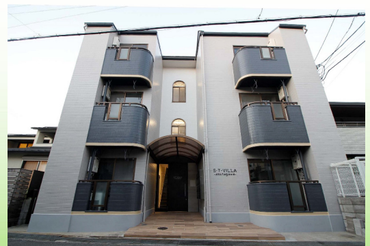
大阪府高槻市 マンション
